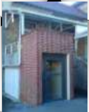
Mise aux normes P.M.R. extérieur.
