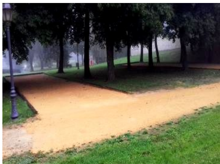
Réfection des terrains de pétanque au parc Salomon de Brosse
