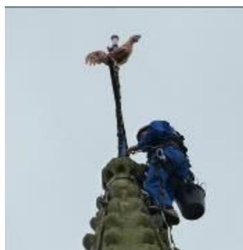
Le cordiste est monté en rappel pour l'installation du paratonnerre. Le coq est monté par l'intérieur de l'église jusqu'au clocher, ensuite par l'extérieur. L'ancien coq décroché sera exposé dans le musée « Mémoire des murs ». Le nouveau coq, en cuivre rouge, fixé prend ses fonctions.
