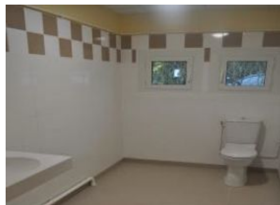
Restaurant scolaire Calmette : création d'un nouveau bloc sanitaire respectant les dimensions P.M.R.
