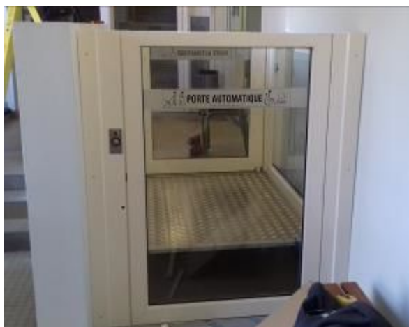
École maternelle Ferry : Accès P.M.R. dans les classes et installation d'un ascenseur
