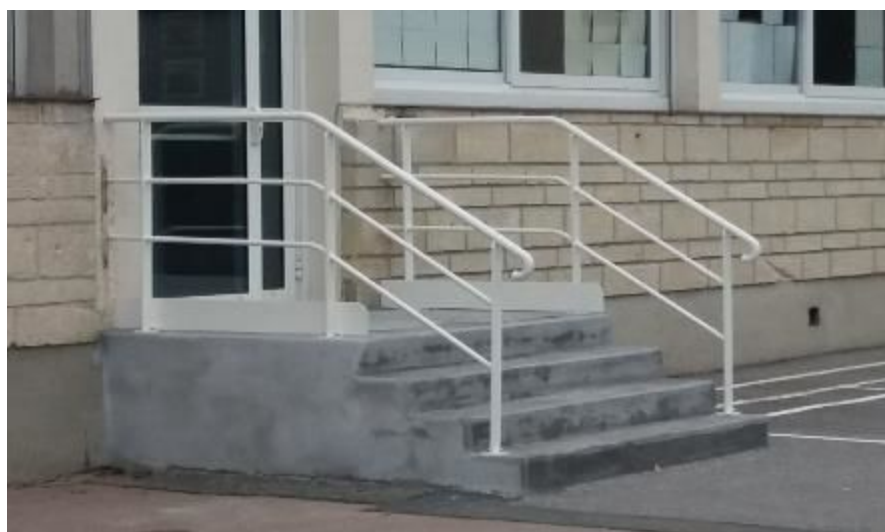
École élémentaire Calmette : réfection de l'escalier et installations de rambardes
