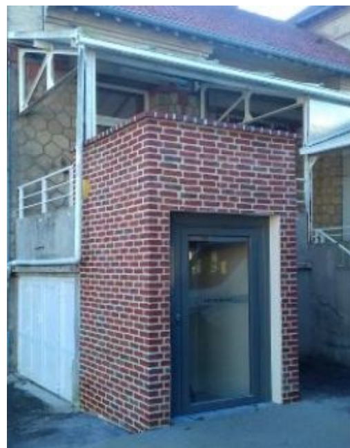
École élémentaire Ferry : Mise aux normes avec un ascenseur P.M.R. extérieur.
