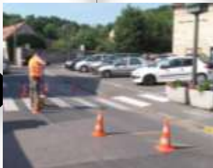
Traçage de la signalisation routière
